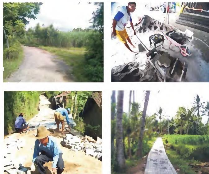
Gambar 1. Prasarana transportasi aspal yang dapat digantikan dengan menggunakan paving serta keterlibatan masyarakat dalam perbaikan dan pemeliharaan jalan
